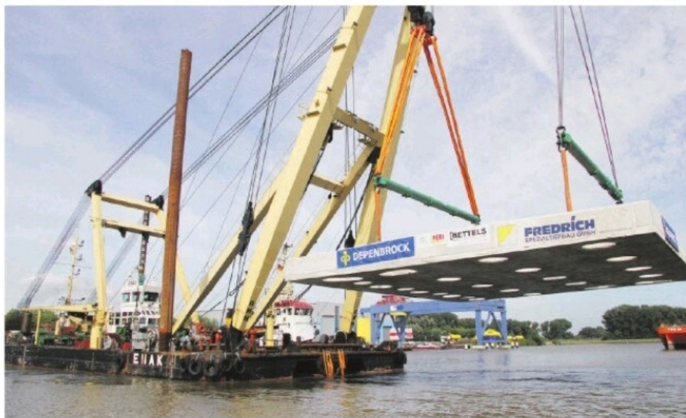
Abgehoben: Gut 375 Tonnen wiegt diese Beton-Plattform für den Flüssiggas-Terminal in Wilhelmshaven. „Enak“ könnte 600 Tonnen tragen.
