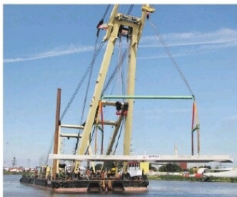
Zum Aufwärmen: Schwimmkran „Enak“ bugsierte zuerst ein 175 Tonnen schweres Betonteil zu einem Ponton.
