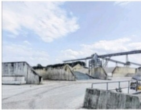
45.000 Tonnen Kies und Sand lagern ständig auf dem Werksgelände und werden in die Betontrommeln gezogen. Das Material kommt per Zug aus Leipzig.
